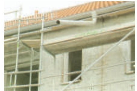
Bild 6 Ableitung von Dachflächenwasser
