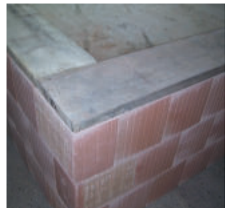
Bild 7 Abdeckung von Mauerkronen mit Dielen
