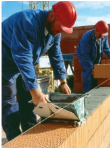
Bild 8 Vollflächiger Mörtelauftrag
