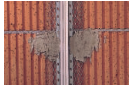
Bild 13 Dehnfugenprofil
