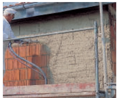
Bild 14 Aufbringen des Unterputzes
