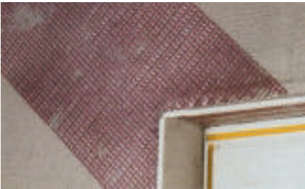
Bild 4 Beispiel einer Diagonalbewehrung
