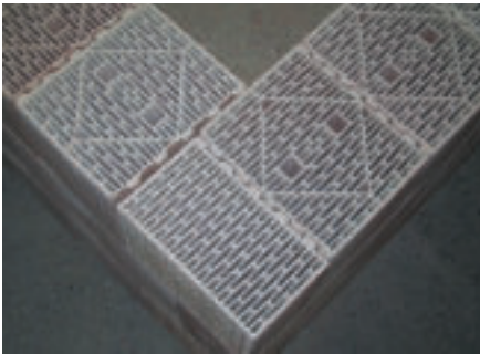
Bild 10 Wandecke mit Eckziegeln
